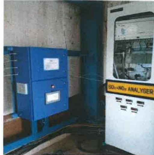
ABB SO 2 , NO x & O 2 analyser
