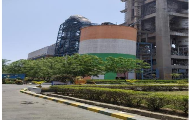
Fly Ash Silo
